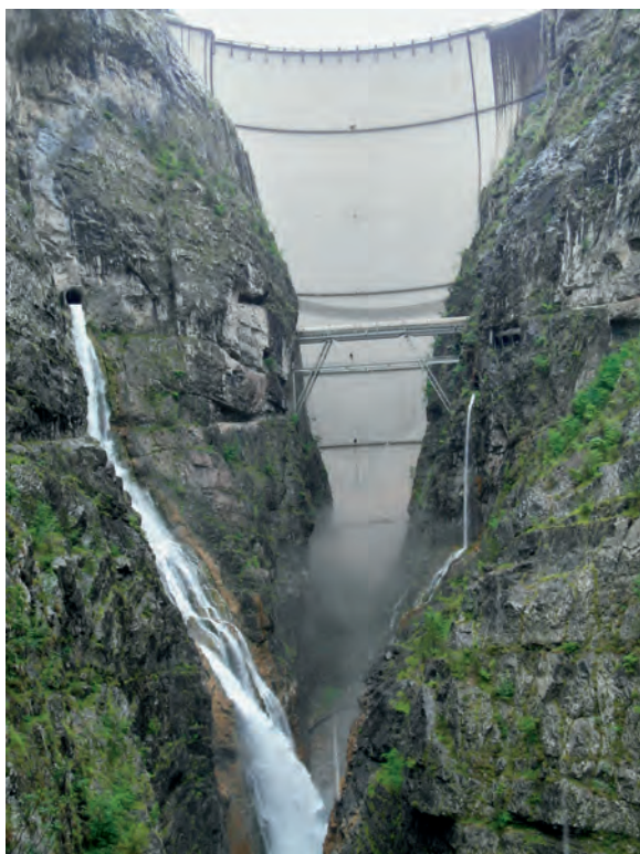
Ryc. 4. Betonowa konstrukcja łukowej zapory Vajont. Ryc. 3 i 4 fot. F. Duszyński Fig. 4. Concrete arch dam of Vajont. Figs 3 and 4 photo by F. Duszyński
