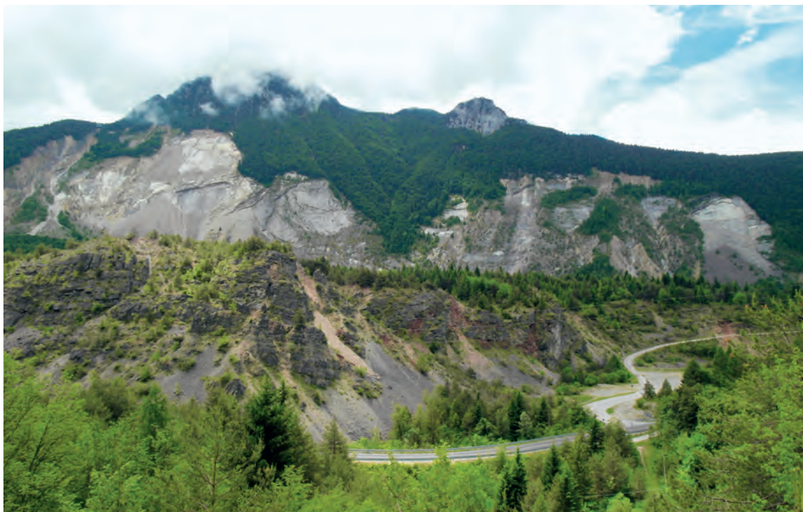
Ryc. 3. Widok na osuwisko Vajont z przeciwległego zbocza doliny Fig. 3. Vajont landslide seen from the opposite side of the valley
