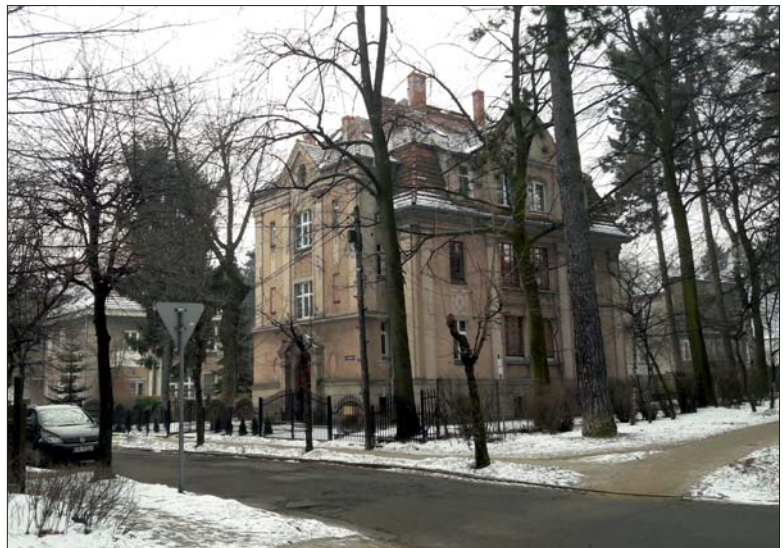
Ryc. 7. Budynek dawnej Stacji Terenowej Państwowego Instytutu Geologicznego w Szczawnie Zdroju przy ul. Słowiańskiej. Fot. M. Kuleszo
