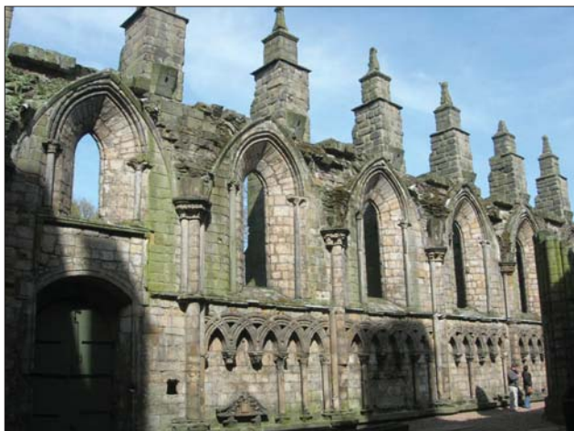
Ryc. 5. Deterioracja biologiczna pozostałości opactwa Holyrood Abbey w Edynburgu. Wapienne i bazaltowe bloki pokryte glonami, porostami i mchami. Fot. M. Ruszkowski
