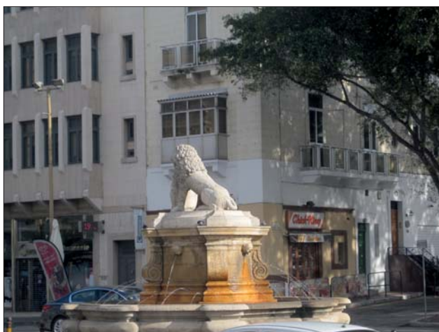
Ryc. 3. Deterioracja chemiczna wapiennej podstawy fontanny w Valletcie na Malcie. Związki żelaza są nanoszone na zabytek przez wodę ze skorodowanej instalacji wodociągowej. Fot. J. Wiszniewska Fig. 3. Chemical deterioration of the calcareous fountain base in Valletta, Malta. Iron compounds are deposited on the monument as a result of corroded water-pipe systems. Photo by J. Wiszniewska
