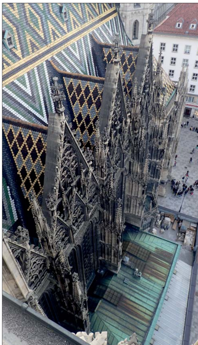
Ryc. 4. Wyraźne procesy deterioracyjne na fasadzie wapienna naw bocznych Katedry w Wiedniu i oczyszczona dzwonnica północna. Fot. M. Ruszkowski
