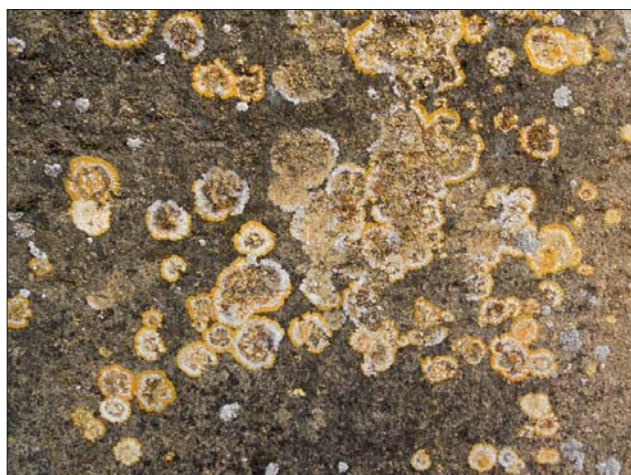
Ryc. 4. Zewnętrzna elewacja romańskiej Bazyliki Najświętszego Serca Pana Jezusa (Basilique du Sacré-Cœur) w Paray-le-Monial (Francja). Zmiany barwne i liczne ubytki na powierzchni wapienia powstałe w wyniku działania porostów
