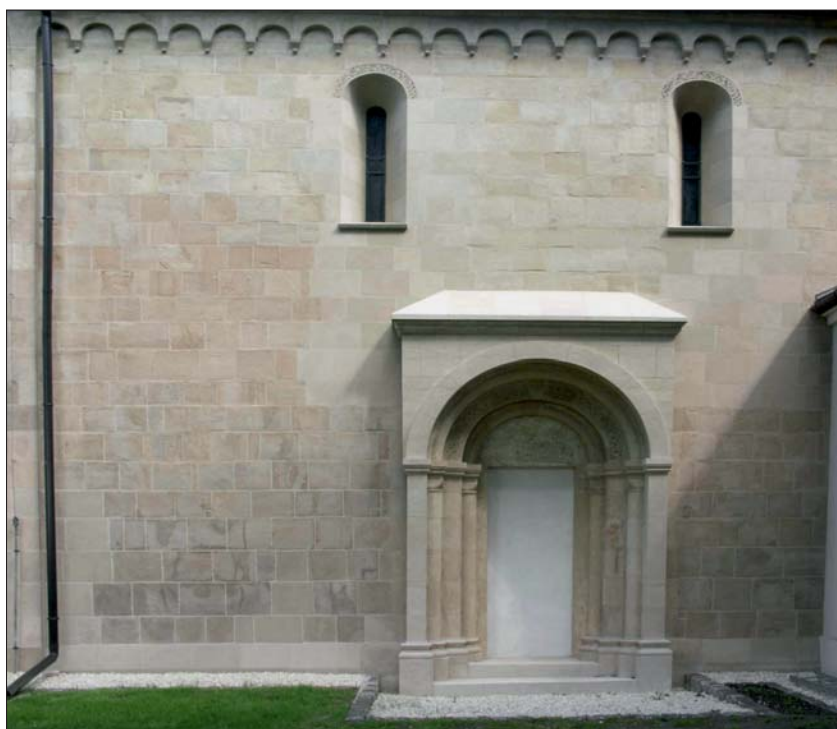
Ryc. 3. Portal w południowej ścianie kościoła w Prandocinie Fig. 3. Portal in the southern wall of the church in Prandocin
