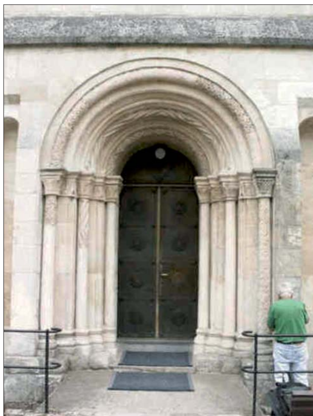
Fig. 13. Domek portalowy zachodniego wejścia. Kościół w Kościelecu Fig. 13. Portal house. Western side of the church in Kościelec
