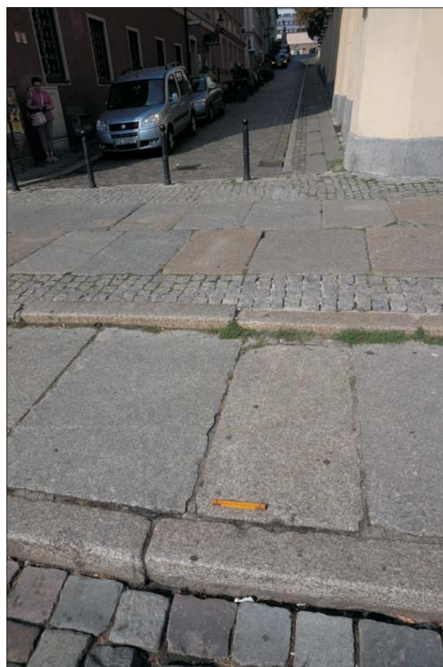
Ryc. 6. Granitowe płyty chodnikowe otoczone drobną kostką granitową i ograniczone krawężnikami z szarego granitu – zachodnia strona Starego Rynku w Poznaniu
