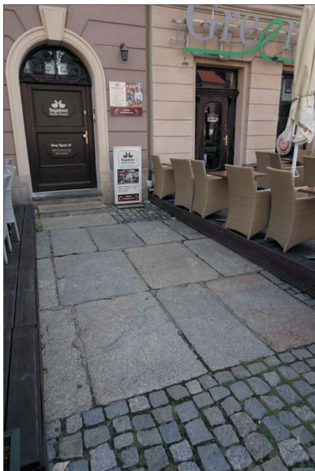
Ryc. 5. Granitowe płyty chodnikowe – otoczone drobną kostką granitową – ułożone pod wschodnią pierzeją Starego Rynku w Poznaniu
