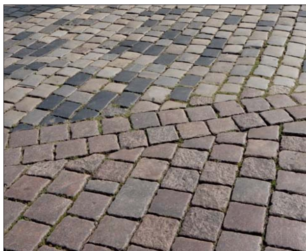
Ryc. 3. Ciemnoczerwone kostki granitowo-gnejsowe, szare kostki granitowe oraz czarne kostki bazaltowe jako uzupełnienie – zachodnia strona Starego Rynku w Poznaniu przed Odwachem (dawną siedzibą straży miejskiej)
