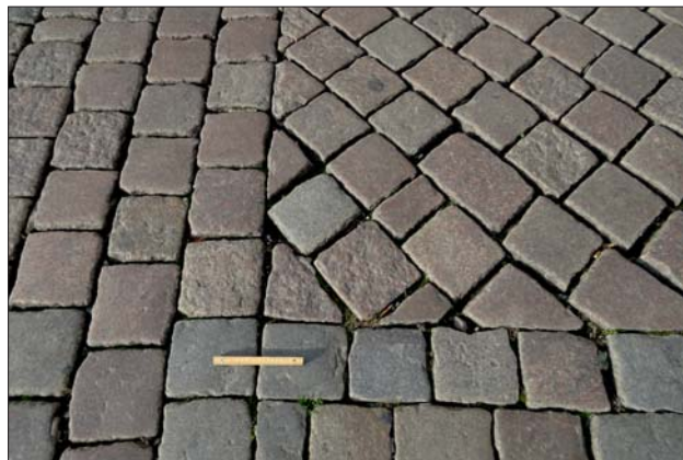
Ryc. 2. Północno-zachodni narożnik Starego Rynku w Poznaniu – połączenie rzędowego ułożenia kostek brukowych z ułożeniem w jaskółczy ogon
