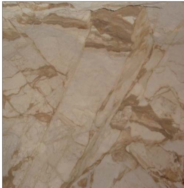
Ryc. 12. Niezabezpieczony przodek jednej z nieukończonych odnog tuneli – widoczna struktura gruntów wokół tuneli wskazuje na niejednorodność materiału (jasne pola – piasek, ciemne grunty pylaste) oraz zaburzenia glaciotektoniczne. Fot. T. Godlewski
