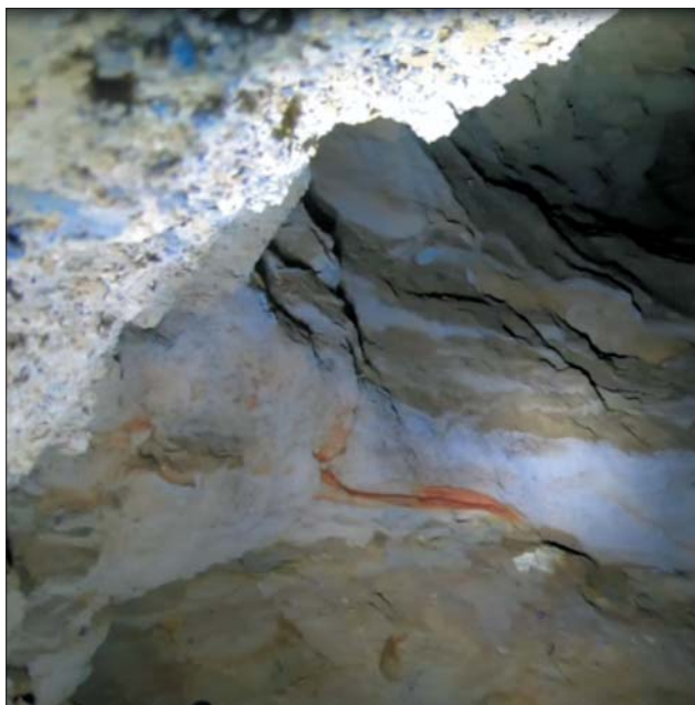
Ryc. 11. Podziemna pustka w okolicy otworu 9 ITB – kamera zwrócona na ścianę boczną, głębokość ok. 13,5 m p.p.t. Widoczna skomplikowana struktura gruntów – naprzemianległe przewarstwienia piaszczysto-pylasto-gliniaste. Fot. T. Godlewski
