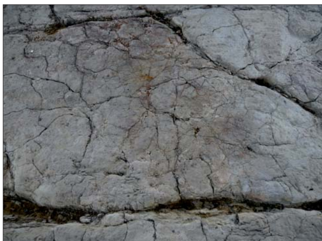
Ryc. 7. Powierzchnia płyty piaskowca po sklejeniu spękań i wykonaniu impregnacji konsolidacyjnej preparatem krzemooorganicznym. Fot. P. Dźwigulska-Musiał
