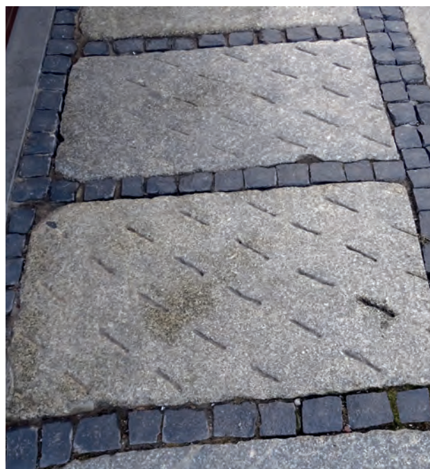
Ryc. 7. Ulica Tylne Chwaliszewo – płyty chodnikowe z reliefem antyślizgowym
