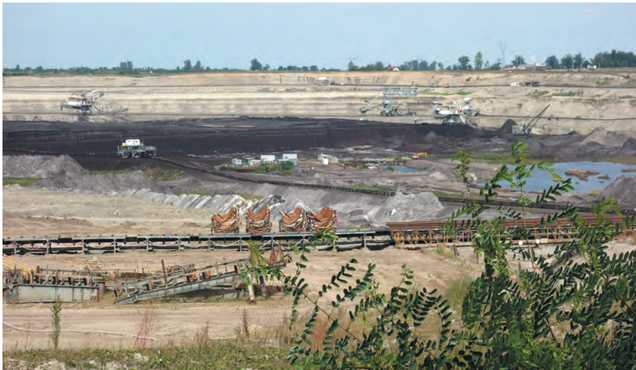
Ryc. 10. Odkrywka węgla brunatnego Tomisławice z systemem odwodnienia spągowego – rząpie w środkowej części fotografii. Fot. M. Widera, czerwiec 2019 r.
