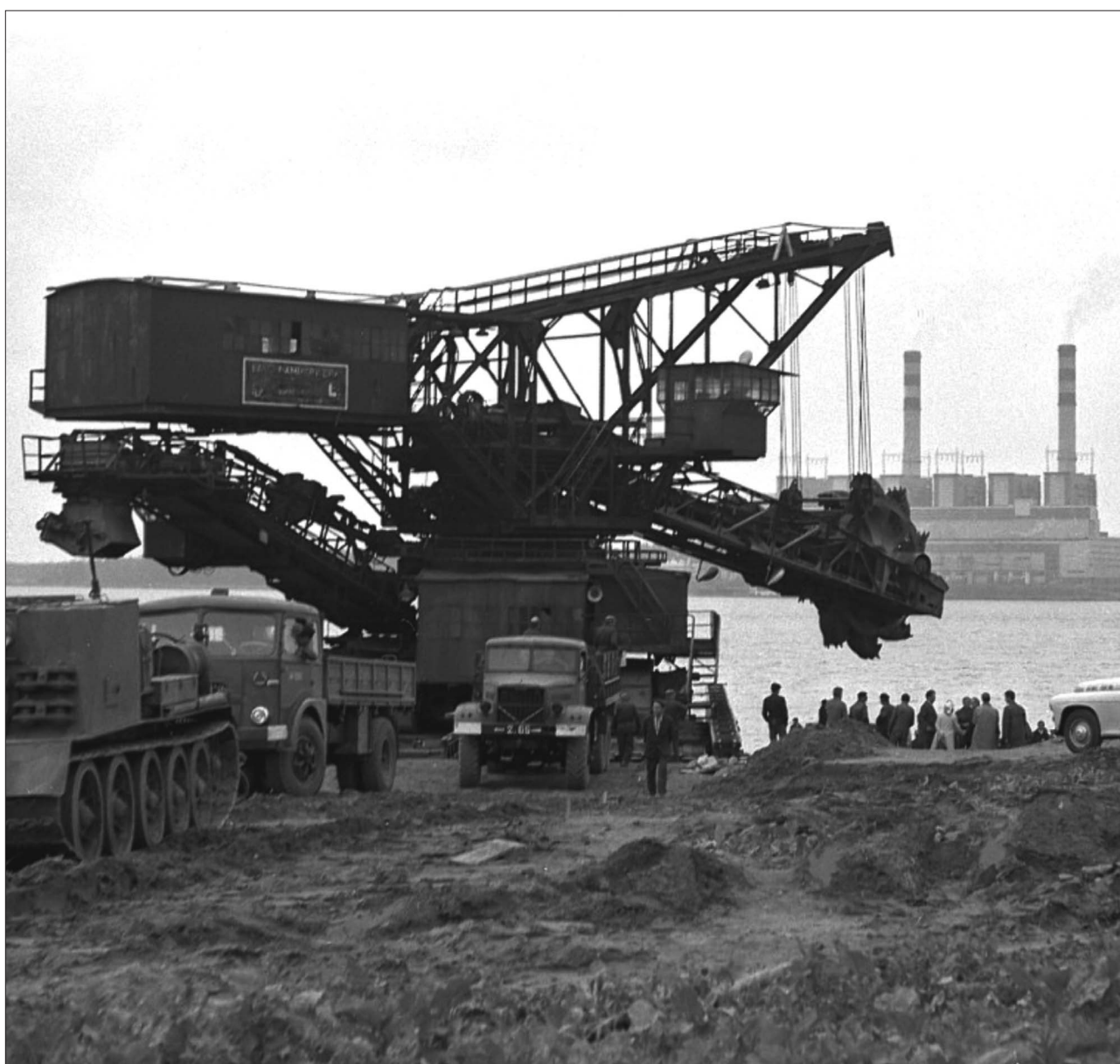
Przygotowanie koparki SchRs 315 do „przerzutu” przez Jezioro Gosławskie w czerwcu 1971 r. W tle widoczna jest Elektrownia Pątnów. Fot. z arch. MOK
