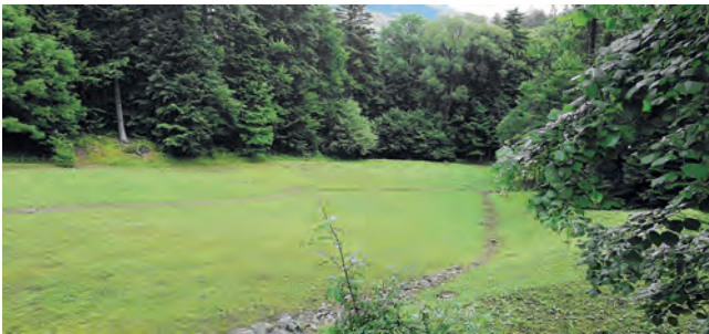
Ryc. 3. Teren zabezpieczonego osuwiska poniżej kaplicy z systemem drenażu powierzchniowego
