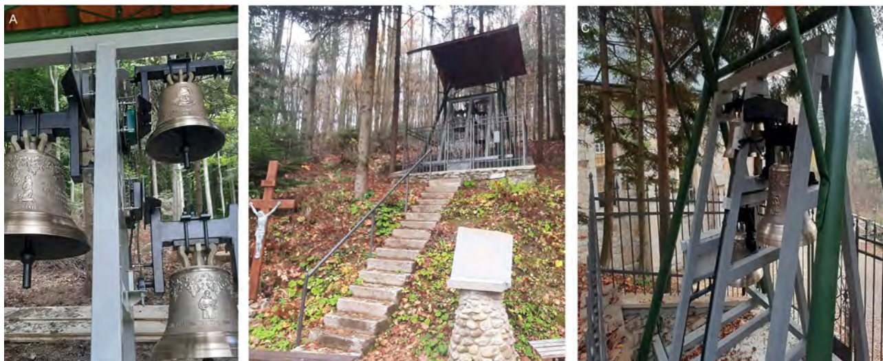
Ryc. 18. Dzwonnica przy kaplicy św. Jana z Dukli po renowacji z kompletem dzwonów; A – dzwony z nowym systemem uruchamiania; B – widok z dołu skarpy; C – widok boczny na dzwonnica i kaplicę
