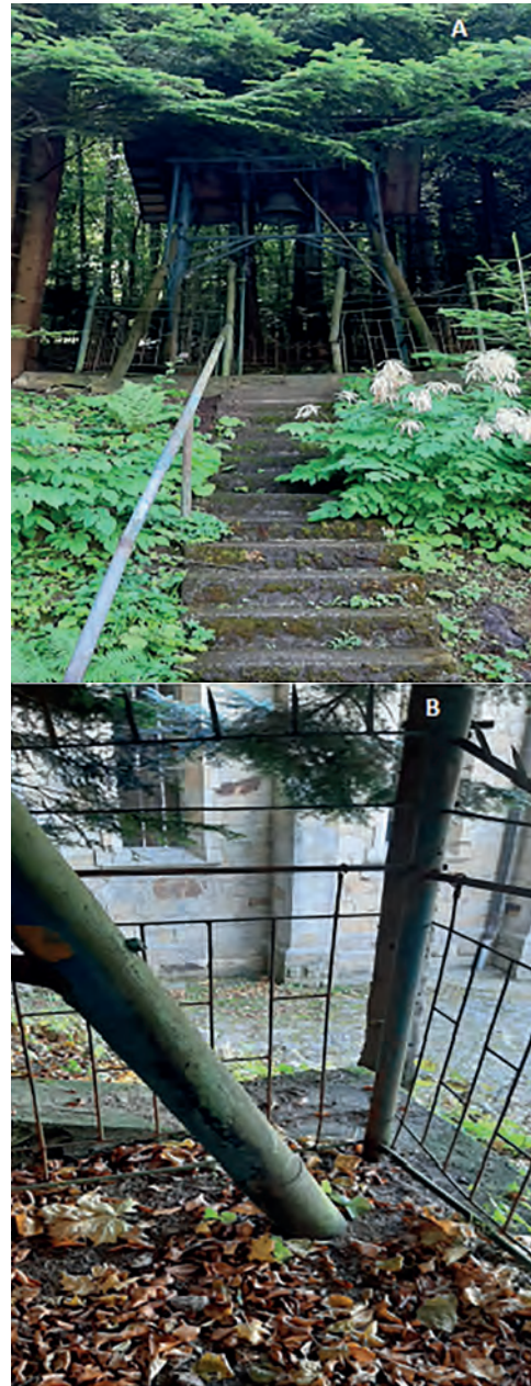
Ryc. 4. Dzwonnica przed renowacją: A – widok z dołu; B – podpora dzwonnicy od strony kaplicy
