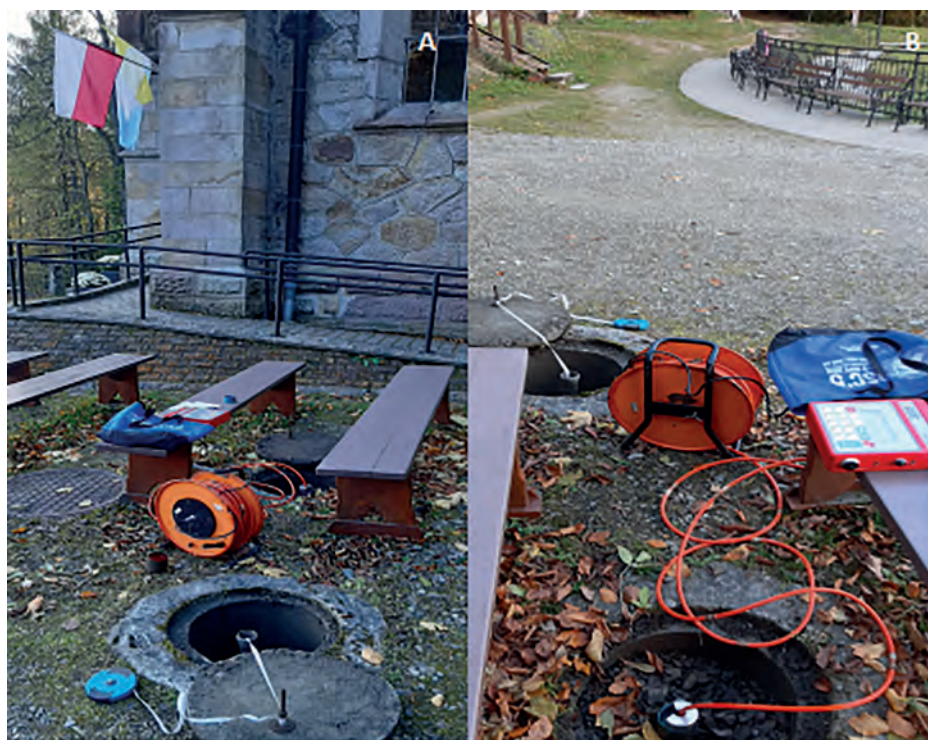
Ryc. 10. Pomiary monitoringowe: A – widok na wschodni narożnik kaplicy; B – Dom Pielgrzymia
