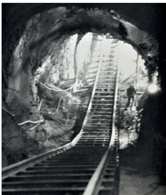
Ryc. 7. Sztolnia ciśnieniowa Fig. 7. Pressure tunnel
