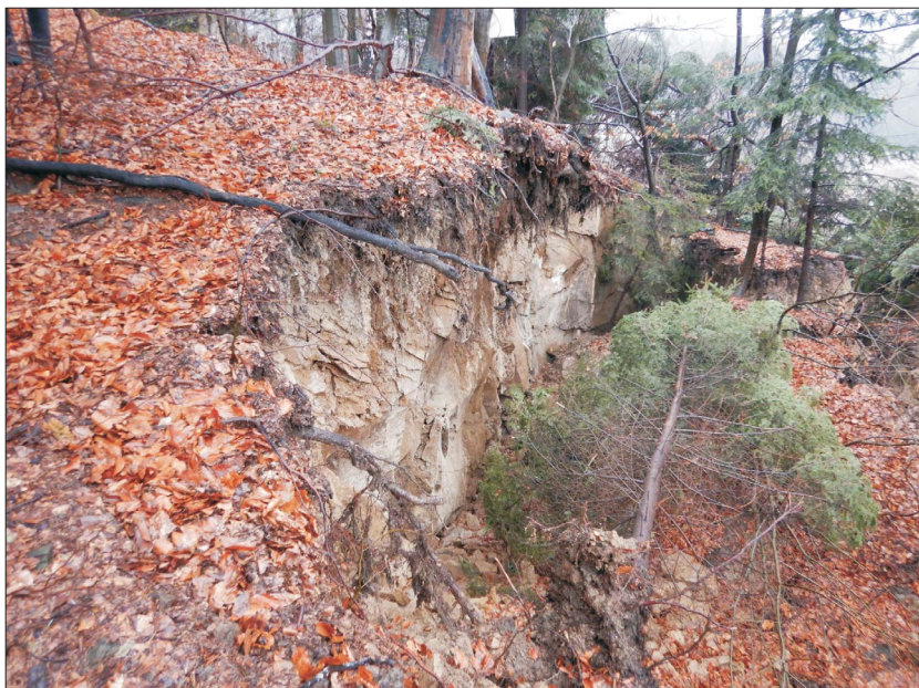
Ryc. 2. Męcina – osuwisko powyżej kamieniołomu. Fot. S. Kamieniarz Fig. 2. Męcina – landslide above the quarry. Photo by S. Kamieniarz
