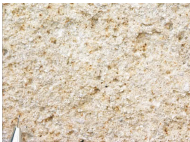
Ryc. 7. Piaskowiec gruboziarnisty z południowej ściany nawy kościoła pw. św. Jana Chrzciciela w Prandocinie. Fot. J. Magiera Fig. 7. Coarse-grained sandstone from the southern wall of the nave of the church of St. John the Baptist in Prandocin. Photo by J. Magiera
