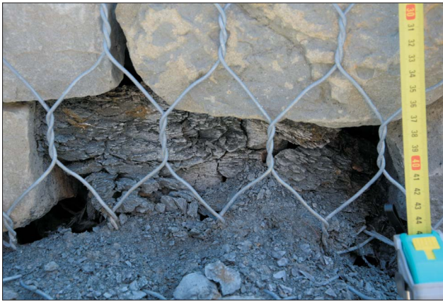
Ryc. 8. Prawie całkowicie rozłożony okrusz mułowca po dwóch latach użytkowania muru. Fot. M. Rembiś
