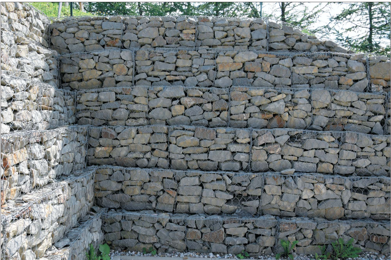
Ryc. 1. Fragment muru gabionowego wykonanego z brył piaskowca karpackiego, 2018 r. Fot. M. Rembiś Fig. 1. Part of a gabion wall made of Carpathian sandstone blocks, 2018. Photo by M. Rembiś
