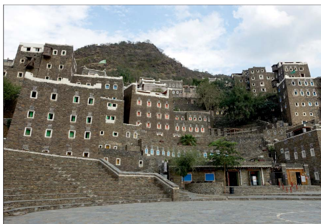
Ryc. 4. Inny przykład zastosowania prekambryjskich łupków krystalicznych jako podstawowego materiału budowlanego – Rial Almaa – miasto 60 pałaców
