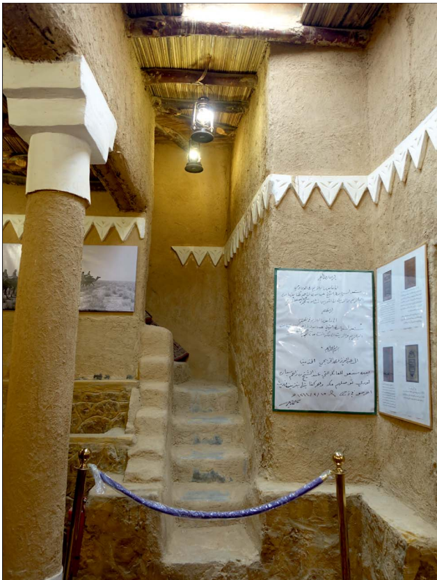
Ryc. 13. Fragment wnętrza tradycyjnego budynku z cegły adobe – Al Quasab
