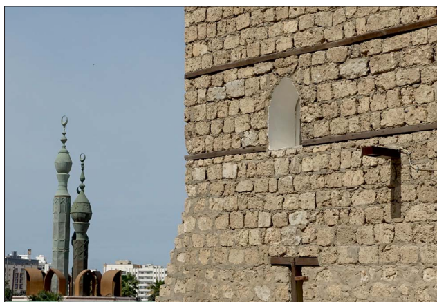
Ryc. 6. Dżedda – fragment bramy miejskiej zbudowanej z wapieni rafowych
