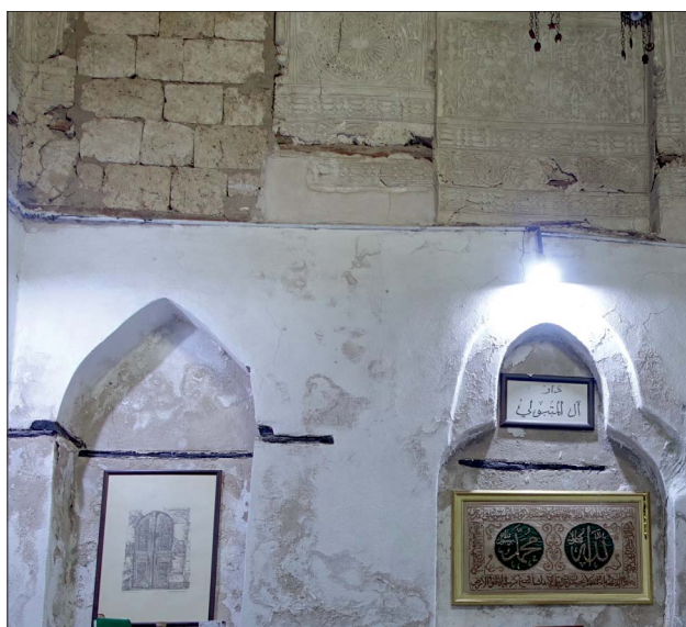
Ryc. 5. Odsłonięty spod tynku fragment ściany z wapieni rafowych jako materiału konstrukcyjnego – dom mieszkalny, Dżedda, stare miasto
