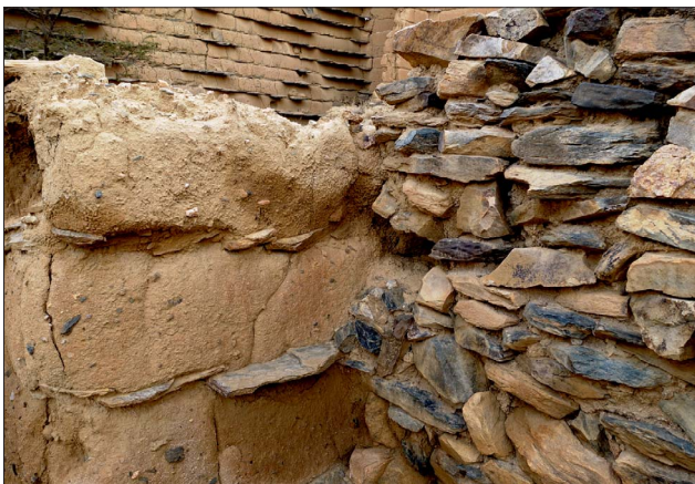
Ryc. 14. Często spotykane łączenie różnych materiałów konstrukcyjnych: kamienia (łupek krystaliczny), cegły adobe (tu formowanej w postaci warstw rozdzielonych łupkiem) i drewna palmowego
