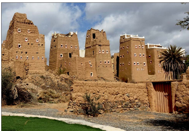
Ryc. 12. Unikatowy charakter miasta o architekturze wieżowej, zbudowanego z cegieł adobe – Dhahran Al Janub w pobliżu miasta Najran i granicy z Jemenem
