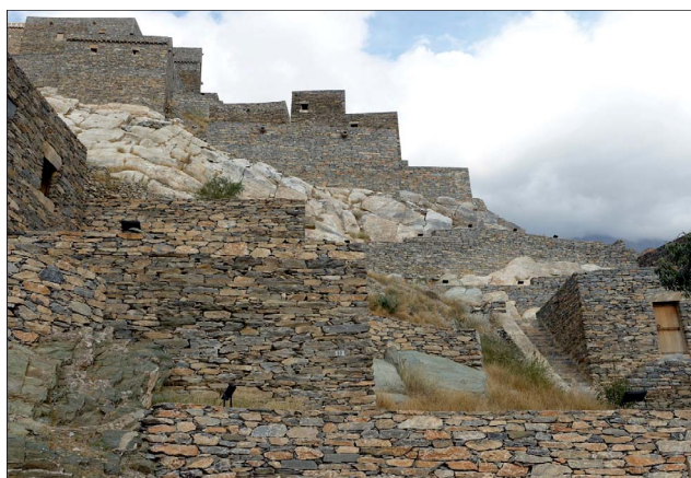
Ryc. 3. Thee Ain – odrestaurowane mury i domy zbudowane z prekambryjskich łupków krystalicznych i marmurów. Widoczne posadowienie budynków bezpośrednio na wychodni marmurów
