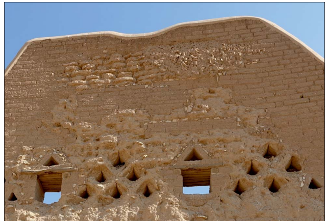
Ryc. 15. Przykład ażurowych dekoracji budynku z cegły adobe – Rijad
