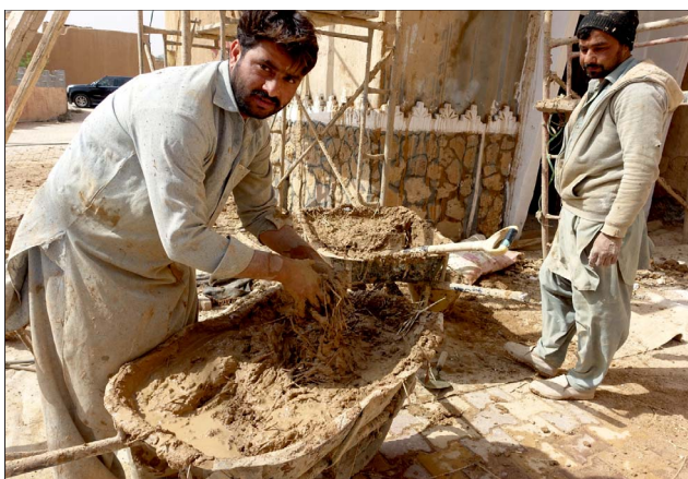
Ryc. 10. Wstępne rozrabianie materiału na cegłę adobe lub zaprawę tynkarską
