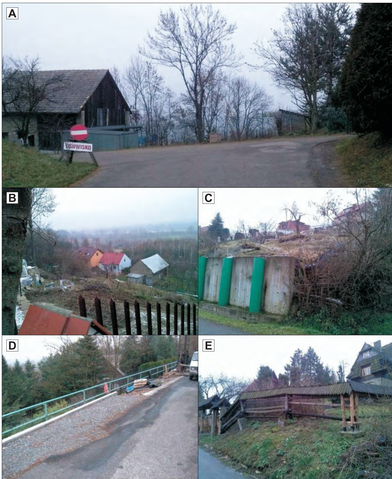
Ryc. 3. Północno-wschodni stok wzgórza Chełm (28.11.2015 r.): A – korona zbocza; B – górna krawędź stoku objęta ruchami osuwiskowymi; C – mur oporowy posadowiony w środkowej części stoku, w rejonie przylegającym do przekroju geologicznego zaznaczonego na ryc. 1; D – uszkodzony odcinek drogi asfaltowej; E – ogrodzenie uszkodzone na skutek powolnych przemieszczeń gruntu Fig. 3. North-eastern slope of Chełm Hill (28.11.2015): A – the upper edge of the slope; B – upper edge of the slope affected by landslide movements; C – retaining wall founded in the middle part of the slope, in the area adjacent to the cross-section marked in Fig. 1; D – damaged section of the asphalt road; E – damaged fence as a result of slow ground displacements
