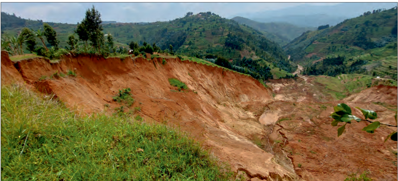
Ryc. 8. Jedno z wielu osuwisk w rejonie miejscowości Karonga (zachodnia Rwanda). Fot. S. Wołkowicz Fig. 8. One of many landslides in the Karonga area (western Rwanda). Photo by S. Wołkowicz
