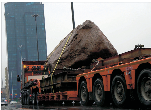
Ryc. 3. Głaz narzutowy wydobyty podczas budowy. Fot. P. Myszak Fig. 3. A boulder excavated during construction. Fot. P. Myszak
