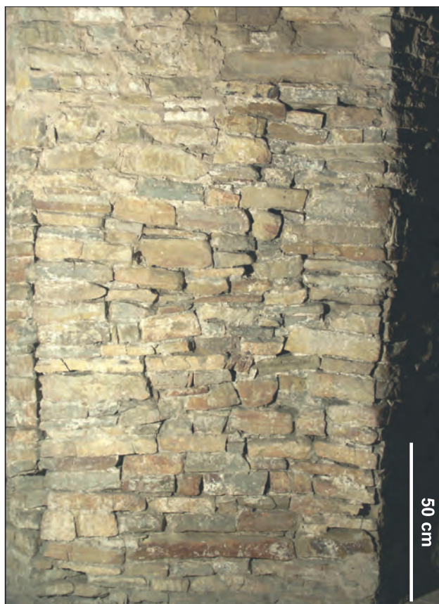
Ryc. 13. Płytki piaskowcowe w murze Rotundy św. św. Feliksa i Aduakta na Wawelu. Fot. J. Magiera
