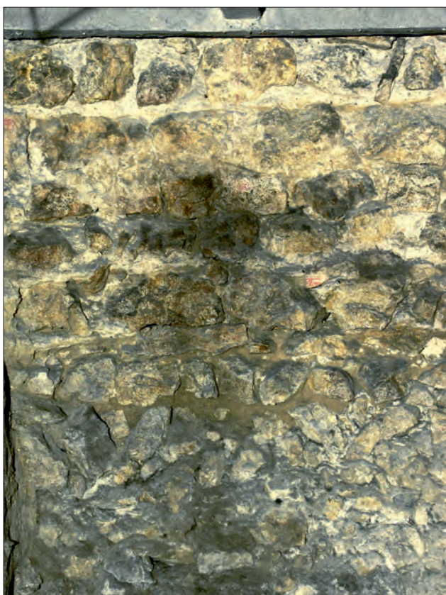
Ryc. 18. Fundament najmłodszego romańskiego Kościoła Najświętszego Salwatora w Krakowie. Fot. J. Magiera Fig. 18. The foundation of the youngest Romanesque Church of the Holy Saviour in Kraków. Photo by J. Magiera
