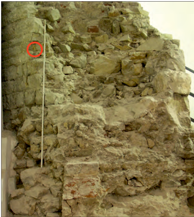
Ryc. 15. Kredowe piaskowce karpackie o podzielności grubopłytkowej w murze wykonanym w technice opus emplectum . Kościół św. Gereona na Wawelu: czerwone kółko – miejsce pobrania próbki. Fot. J. Magiera
