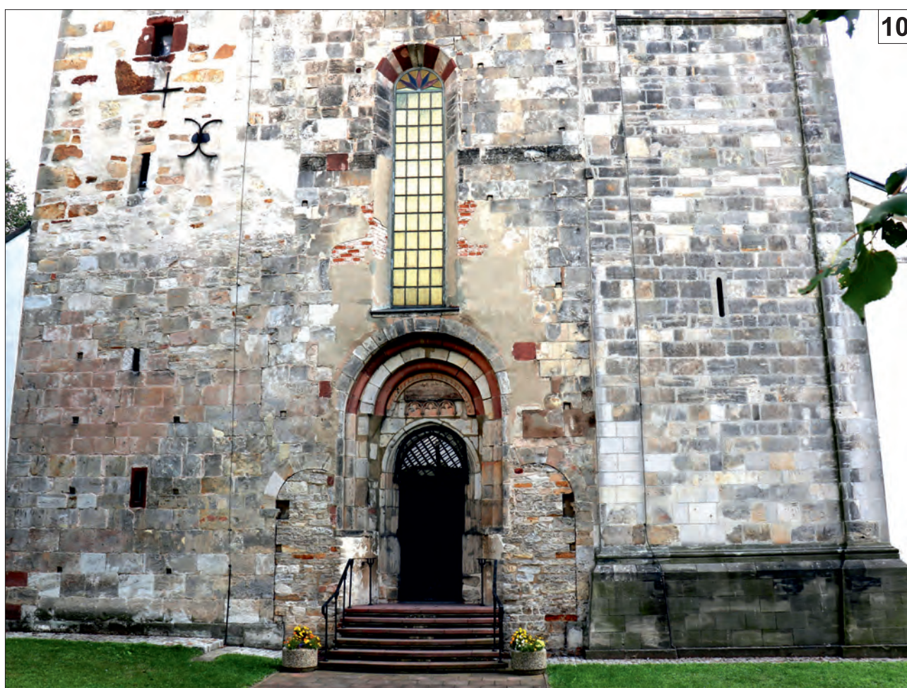
Ryc. 9 i 10. Zachodnia fasada kolegiaty opatowskiej. Widoczne łączenie romańskiego muru wieży północnej z murem odbudowanym. Fot. J. Magiera
