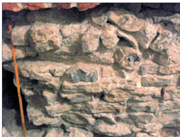
Ryc. 14. Płytki wapienne i pojedyncze piaskowcowe w murze katedry chrobrowskiej na Wawelu. Fot. J. Magiera
