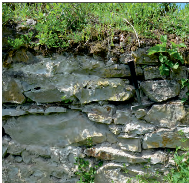
Ryc. 8. Pozostałości murów piwnic (?) zbudowanych z dolnokambryjskich piaskowców z Ossolina. Fot. A. Fijałkowska-Mader
