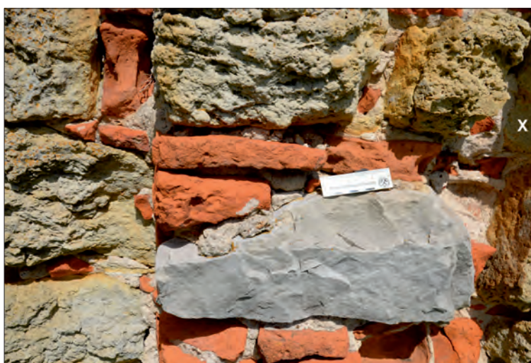
Ryc. 13. Fragment ściany budynku bramnego, zbudowanej z bloków zbioturbowanego piaskowca formacji z Ociesek (?), cegieł i pojedynczych bloków piaskowca z Ossolina. Fot. A. Fijałkowska-Mader
