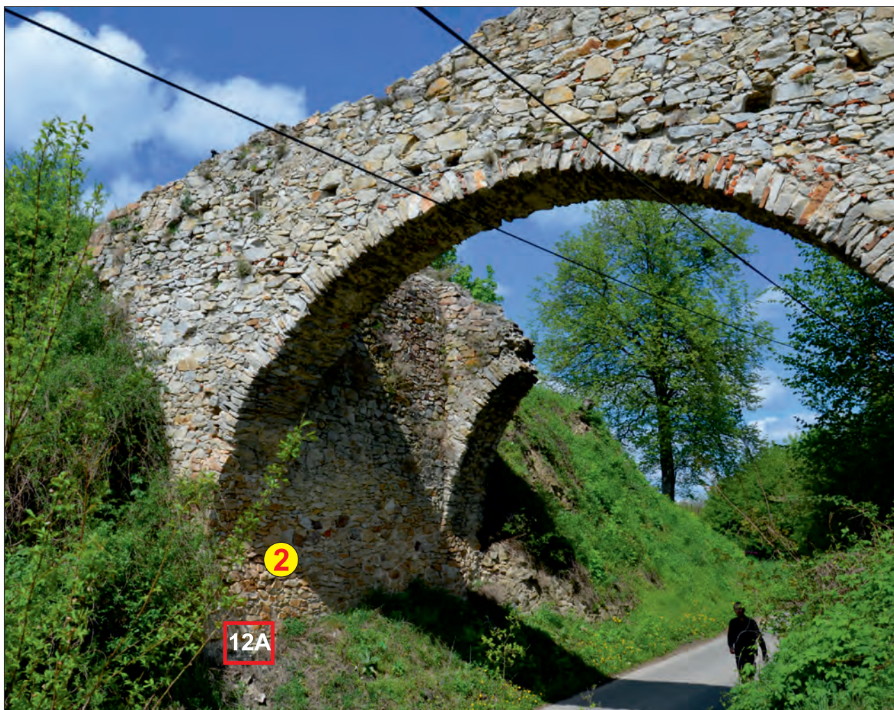
Ryc. 7. Południowa arkada mostu zbudowana z dolnokambryjskich piaskowców z Ossolina: 12A – fragment zdjęcia powiększony na ryc. 12A; 2 – miejsce pobrania próbki do badań petrograficznych. Fot. A. Fijałkowska-Mader
