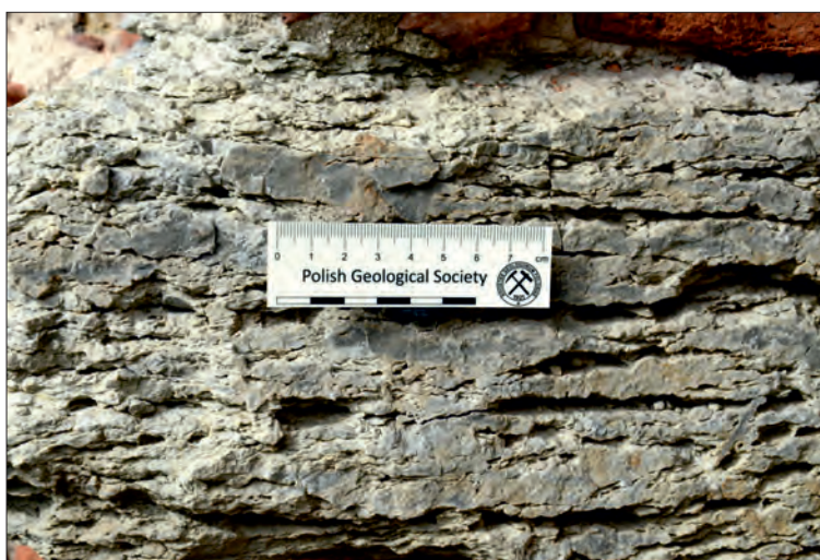
Ryc. 14. Blok zbioturbowanego piaskowca o cechach pośrednich między piaskowcem z Ossolina a piaskowcami formacji z Ociesek w ścianie budynku bramnego. Fot. A. Fijałkowska-Mader
