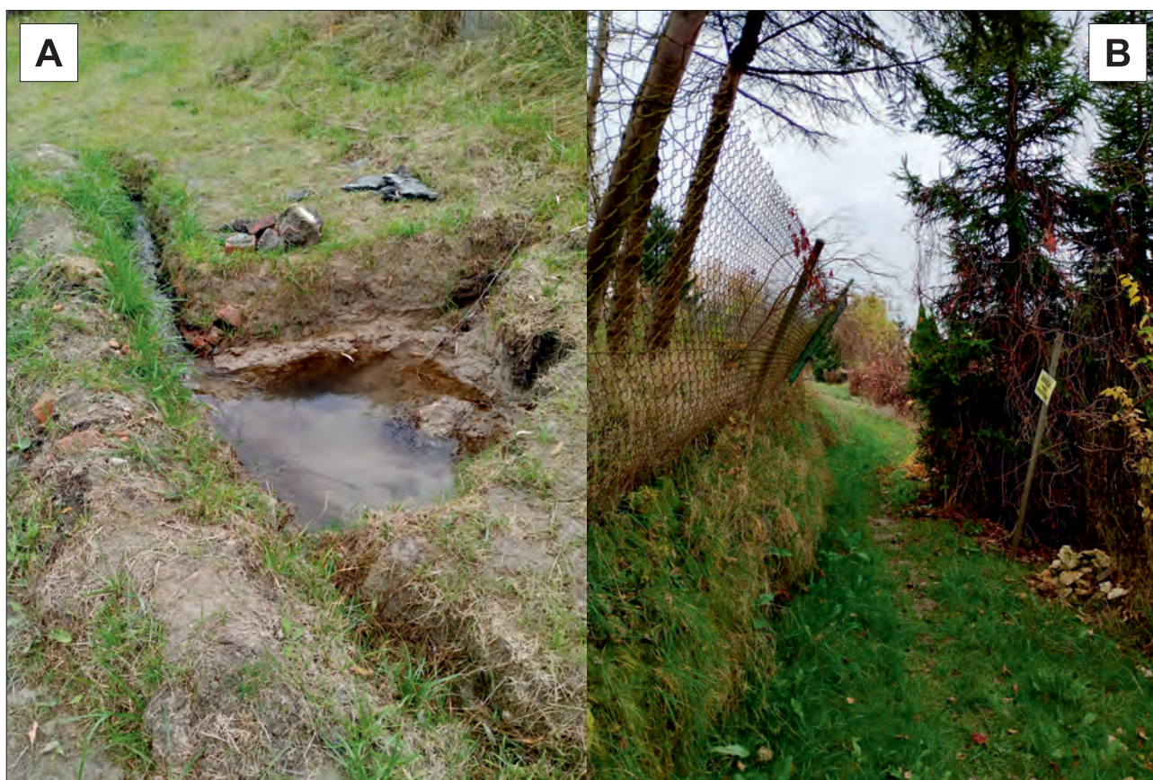
Ryc. 10. Obszar osuwiska 85904: A – uszkodzony wodociąg Ø600 mm; B – przemieszczający się próg akumulacyjny (Czernek, Żabczak, 2024)
