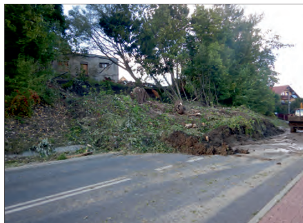
Ryc. 2. Osuwisko w Bielsku-Białej, wrzesień 2024 r. Fot. S. Kamieniarz Fig. 2. Landslide in Bielsko-Biała, triggered in September 2024. Photo by S. Kamieniarz
