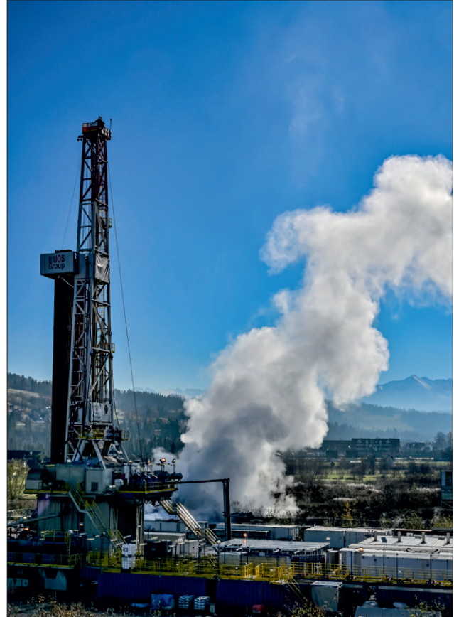
Ryc. 1. Odwiert Bańska PGP-4. Arch. PROINSOL Sp. z o.o. Sp.k.
