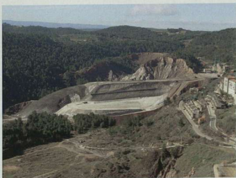
Cardona. Kopalnia soli kamiennej.
