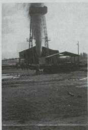
Wyrzut płuczki z otworu wiertniczego Otyń IG-1 (fot. Emil Markulis, 1963)
