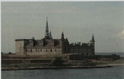
Widok na zamek Kronborg od strony cieśniny.
