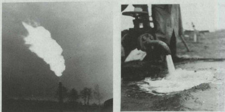
Spalanie gazu ziemnego podczas badania zasobów (z lewej). Odpuszczanie koncentratu gazowego z separatora (z prawej). (fot. Z. Werner, 1963)
