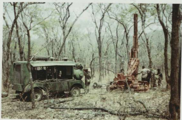
Aparat wiertniczy, obrotowy, z kompresorem.
