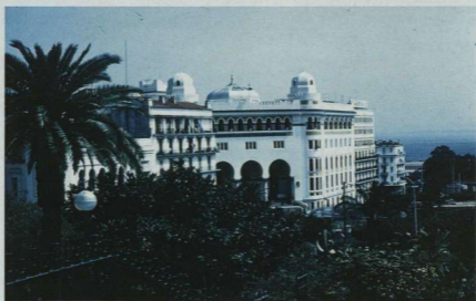
Algier, jedna z ładniejszych budowli to poczta.
