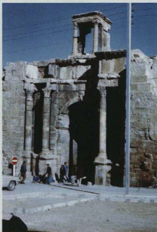
Tebessa. Antyczna brana miejska.
