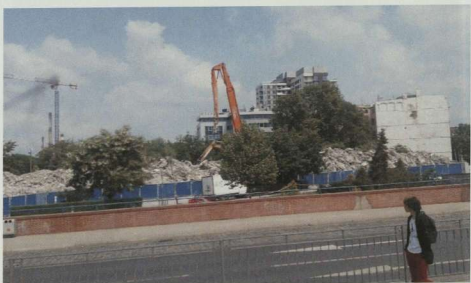
Budynek Cuprum w przeszłości (zdjęcie górne) oraz jego szczątki w 2020 r. (zdjęcie dolne)
