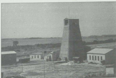
Szyb wschodni L-III kopalni Lubin i najbliższe otoczenie widziane z wieży triangulacyjnej. Tak wygląda wieża szybu w trakcie jego głębenia, lipiec 1961 r.
