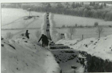
Fot. 1. Badania geologiczno-inżynierskie dna przyszłego zbiornika Czorsztyn-Nidzica były prowadzone także zimą 1951/1952 r. przy temp. bliskiej 0°C
