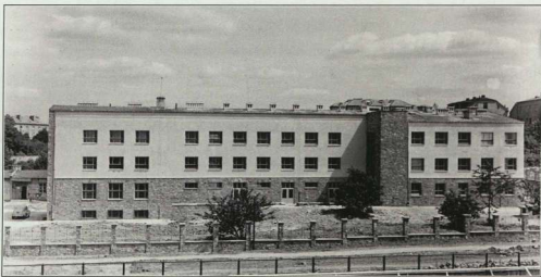
Fot. 4. Zakończenie budowy Stacji Świętokrzyskiej PIG, sierpień 1961 r. Po lewej stronie zdjęcia widoczny fragment baru, który był siedzibą stacji w latach 1955–1961. Fot. H. Topaczewska
