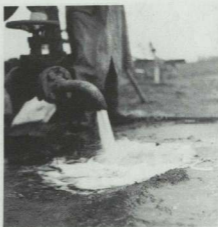
Spalanie gazu ziemnego podczas badania zasobów (z lewej). Odpuszczanie koncentratu gazowego z separatora (z prawej). (fot. Z. Werner, 1963)
