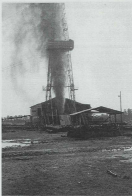
Wyrzut płuczki z otworu wiertniczego Otyń IG-1, 1963. (fot. Emil Markulis)
