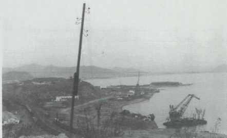
Budowa portu w Nachodce (fotografia wykonana z ukrycia), 1962 r.
