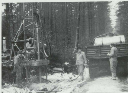
Lasy na północny-wschód od Nieklania, 1978 r.; płytkie wiercenie (do głębokości około 20 m) aparatem wiertniczym umieszczonym na samochodzie, wykonywane w poszukiwaniu ilów ochrowych.
