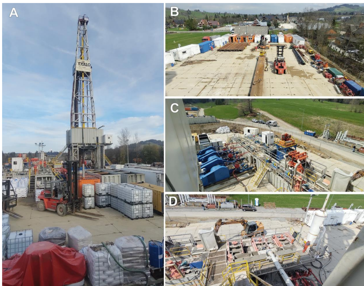
Fig. 3.3.3. Teren wiertni. A – wieżomaszt z zapleczem materiałowym, B – plac manewrowy z zapleczem socjalno-biurowo-magazynowym, C – pompy płuczkowe wraz ze zbiornikami na płuczkę, D – system oczyszczania płuczki (sita wibracyjne) (Fot. B. Bielec)
