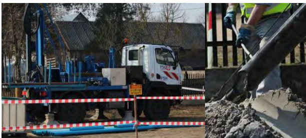
Wiertnica Samodzielnej Sekcji Wiertniczej PIG-PIB w trakcie wykonywania piezometru sieci obserwacyjno-badawczej wód podziemnych
