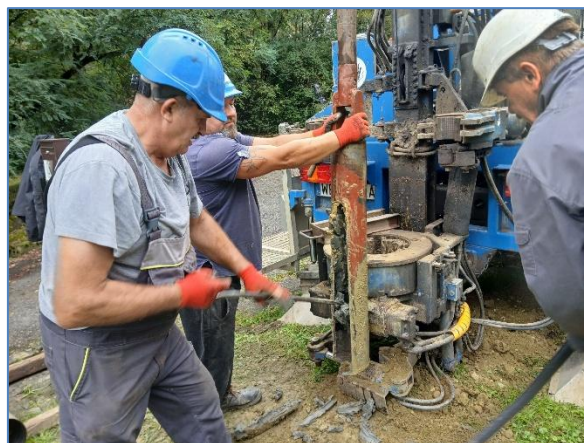
Ryc. 11.4. Wiercenie otworu obserwacyjnego w miejscowości Pogwizdów, gm. Hażlach (wrzesień 2025 r.)
