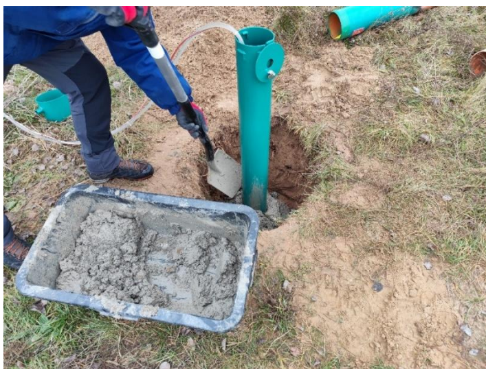
Ryc. 9.2. Punkt obserwacyjny II/1425 Giżałki (woj. wielkopolskie) w trakcie prac związanych z wymianą obudowy piezometrycznej.
