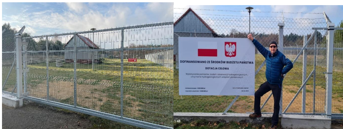
Ryc. 9.7 Ogródzenie terenu stacji hydrogeologicznej I650 Rudnica (woj. lubuskie).
