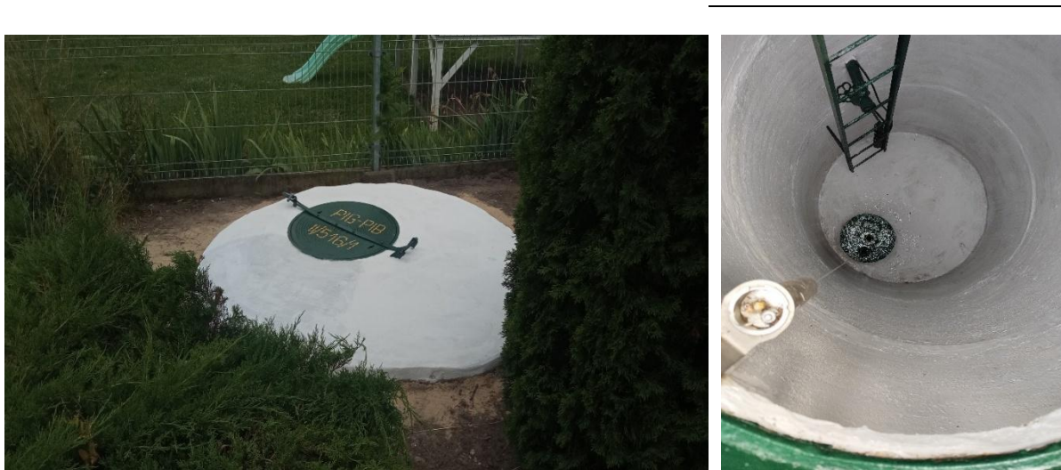
Ryc. 9.5 Punkt SOBWP numer II/516/1 Żudź (woj. lubelskie) po wykonaniu prac remontowych, po lewej widoczny moduł automatyki pomiarowej.
