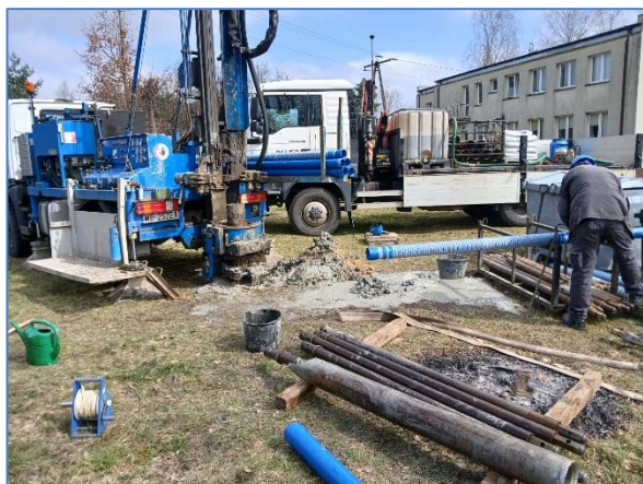
Ryc. 11.3. Wiercenie otworu obserwacyjnego w miejscowości Krasna, gm. Stąporków (marzec 2025 r.)
