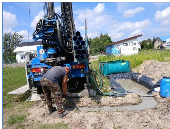
Ryc. 11.2. Wiercenie otworu obserwacyjnego w miejscowości Kopytów, gm. Kodeń (sierpień 2025 r.).
