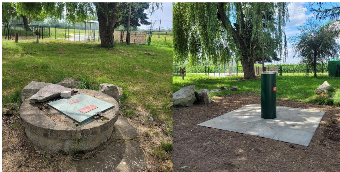
Ryc. 9.8 Stacja hydrogeologiczna II/1407 Pobiednik (woj. małopolskie) – zamiana obudowy kręgowej podziemnej na rurową powierzchniową.
