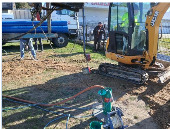
Ryc. 11.6. Pompowanie i prace porządkowe po wierceniu otworu obserwacyjnego w miejscowości Siemień, gm. Siemień (kwiecień 2025 r.)
