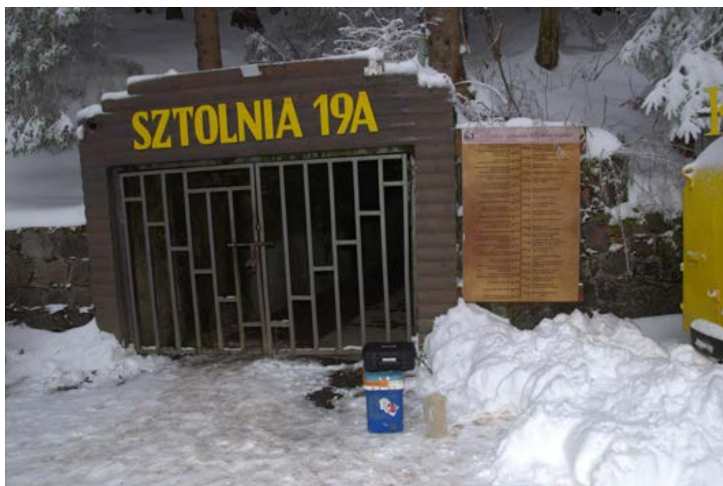
Fot. 5.3.1.2. Wejście do sztolni 19A w Kowarach-Podgórzu, 2023 r. (zdj. M.R. Kłonowski)
