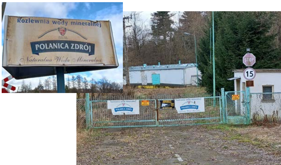
Fot. 5.3.7.1. Sztyl, brama wjazdowa i budynki byłej rozlewni „Polanica Zdrój” w Starym Wielisławiu, 2023 r. (zdj. M.R. Klonowski)
