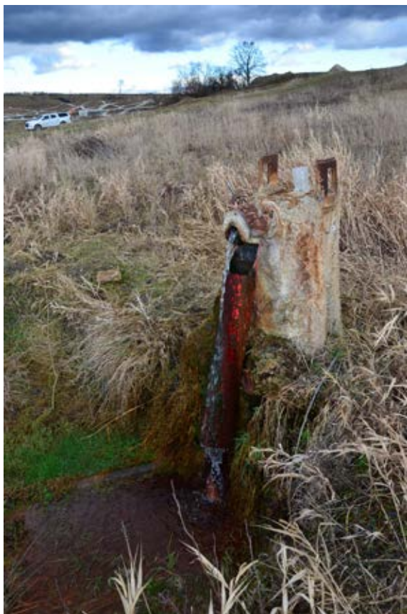
Fot. 5.3.2.1. Samowypływ z otworu 11R w rejonie Krosnowic, 2023 r. (zdj. M.R. Klonowski)
