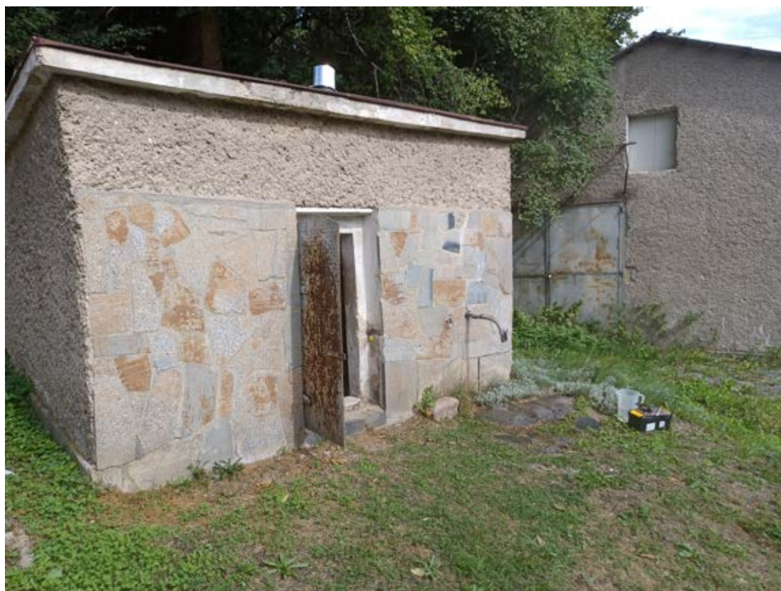
Fot. 5.3.4.2. Budynek ujęcia „Źródło Siarczkowe” w Opolnicy, 2022 r. (zdj. M.R. Kłonowski)
