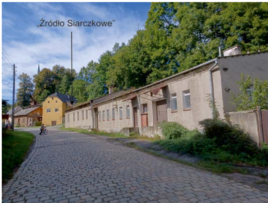
Fot. 5.3.4.1. Budynki byłej rozlewni wody „Opolniczanka” w Opolnicy, 2023 r. (zdj. M.R. Kłonowski)
