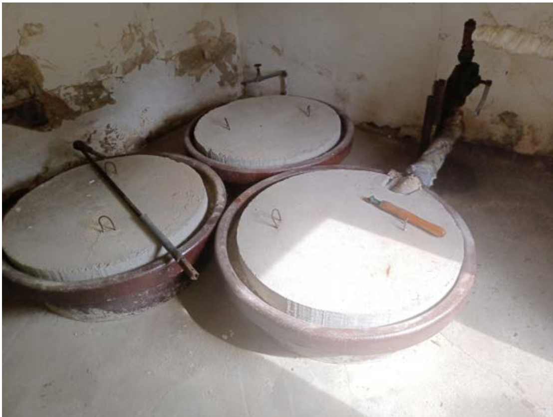
Fot. 5.3.4.3. Wnętrze budynku ujęcia „Źródła Siarczkowego” i obudowa źródła, 2022 r. (zdj. M.R. Klonowski)
