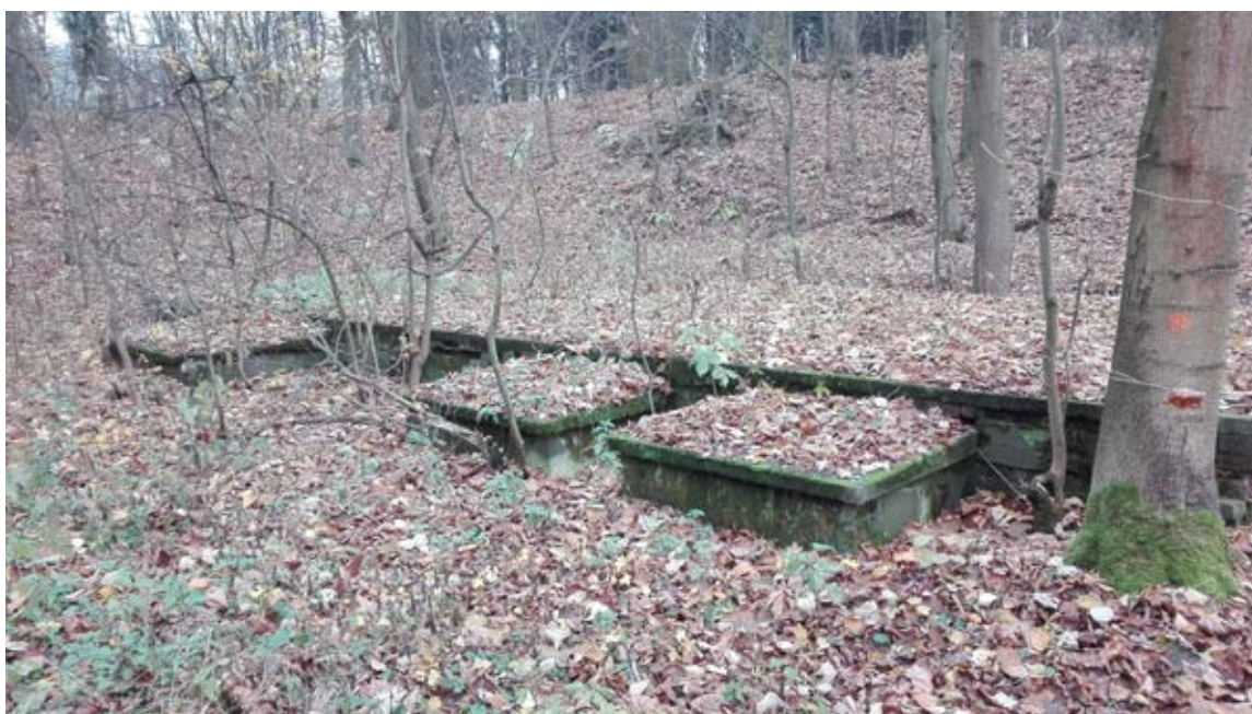
Fot. 4.1. Fundamenty pawilonu stojącego nad źródłem Jadwiga w Starych Rochowicach, 2022 (zdj. M.R. Kłonowski)
