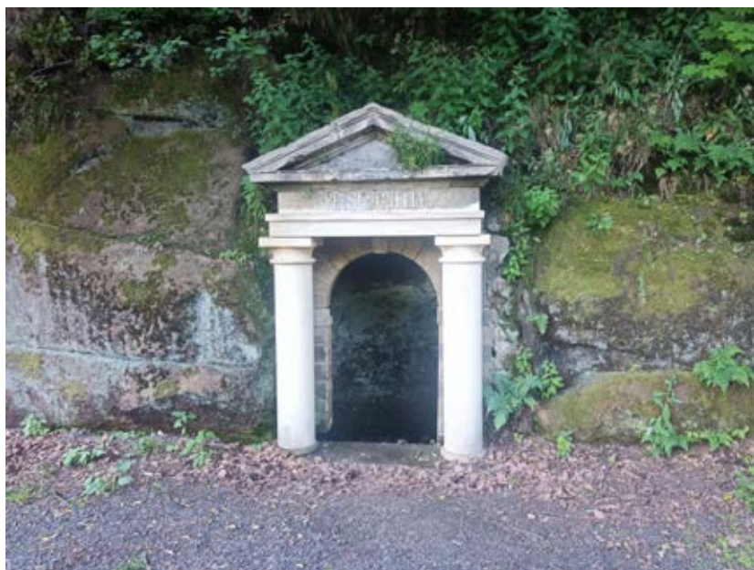
Fot. 4.4. Ujęcie „Skalnego Źródła” w Jerzmanicach-Zdroju, stan po renowacji w 2021 r. (zdj. A. Kowalski)
