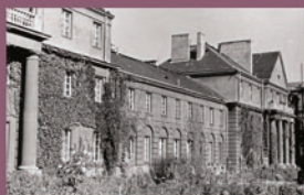
Odbudowę po wojnie gmach południowy (budynki B) z osiedkiem. Lata 50 XX-wieku.
