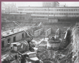
Wykop pod fundament nowego gmachu (1949 r.). Widoczny w środku okrągły sztyb betonowy – pozostałość po zburzonym powłocie geofizycznym.
