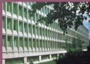
Nowy gmach PIG przy ul. Rakowieckiej. Wykorzystana przez M. Legka technologia konstrukcji szkieletowej wypełniona była prostymi prefabrykami stanowiącymi jednocześnie elewację budynku.
