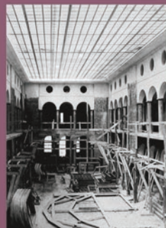
Budowa głównego gmachu PIG w latach 1928-1934. (Sala Muzeum Geologicznego). Sala korpusu głównego została przekryta szklonym dachem o konstrukcji żelaznej w sekcjachowej o 17 metrach wysokości.
