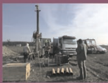
Wiercenia geologiczno-inżynierskie o głębokości 50 m metodą obrotową rdzeniową w Leszczach.
