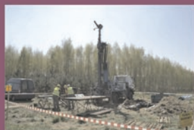
Wiercenie obserwacyjnego otworu hydrogeologicznego w Jankowicach.
