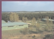
Hale magazynowe Archiwum Rdzeni w Kielnikach.
