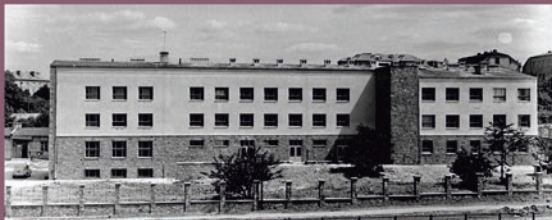
Budowa Stacji Świętokrzyskiej PIG zakończona, sierpień 1961. W tle po lewej stronie zdjęcia widoczny budynek, który był siedzibą stacji w trakcie budowy nowej siedziby (fot. H. Topaszewska).
