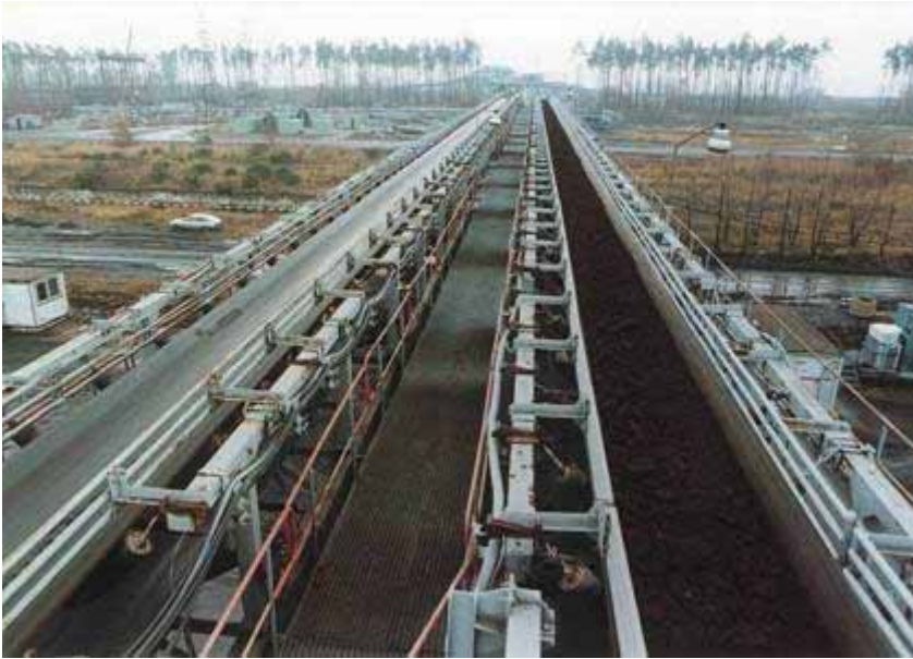
Rysunek 33. Układ przenośników taśmowych w KWB „Belchatów” –projekt Poltegor-Projekt, wykonanie FUGO Konin
