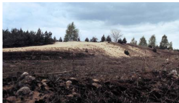
ryc. 17: Droga Boxberg – Weißwasser przecinająca wydmy.
