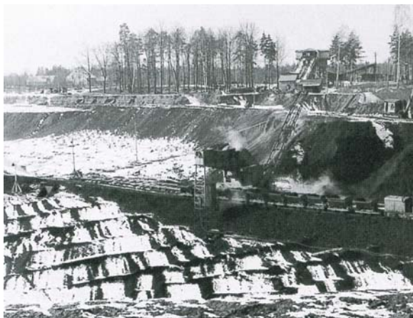
ryc. 28: Wydobywanie węgla brunatnego metodą odkrywkową w kopalni „Pokój” w okolicach miejscowości Halbendorf przy pomocy niewielkich koparek tańczuchowo-kubelkowych. Zdjęcie wykonano ok. 1953 r.
