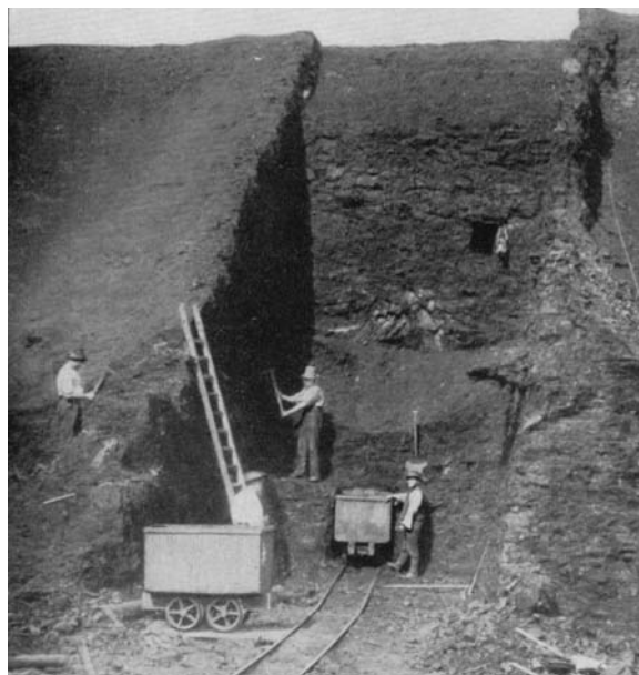
ryc. 27: Wydobywanie węgla brunatnego metodą „Schlitzschurrenabbau”. Górnicy ręcznie urabiali węgiel ze ściany (pokładu). Praca górników była bardzo ciężka.
