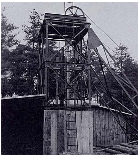
ryc. 26: Typowy szyb wydobywczy w kopalni „Conrad” w okolicach miejscowości Groß Köllzig. Zdjęcie wykonano ok. 1953 r. Dzisiaj na Łuku Mużakowa nie ma już żadnych wież wydobywczych.
