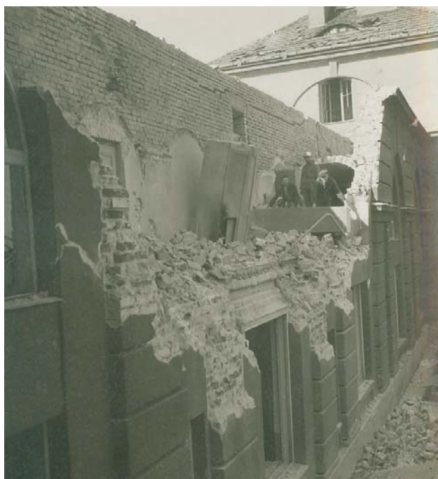
Ryc. 5. Zniszczony budynek instytutu (łącznik pomiędzy budynkami B i C)
