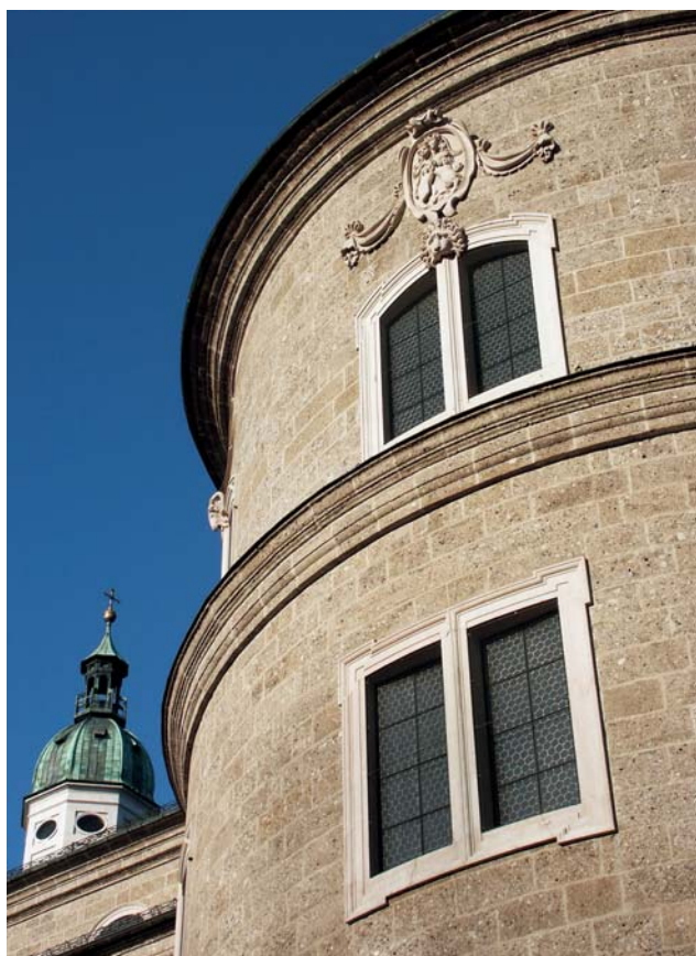
Ryc. 2. Fragment południowej elewacji katedry salzburskiej zbudowanej ze zlepieńca Mönchsberg. Fot. R. Kryza
