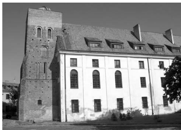
Ryc. 2. Budynek Gimnazjum Gubernialnego w Płocku — stan aktualny. Fot. M. Graniczny
