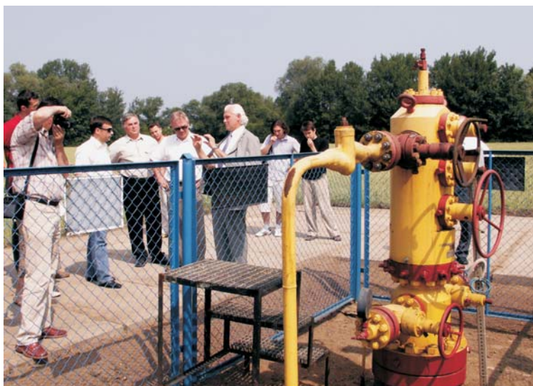
Ryc. 3. Przedstawiciel PGNiG S.A. Piotr Krępulec objaśnia proces zatłaczania CO 2 — na pierwszym planie głowica odwiertu zatłaczającego w Borzęcinie
