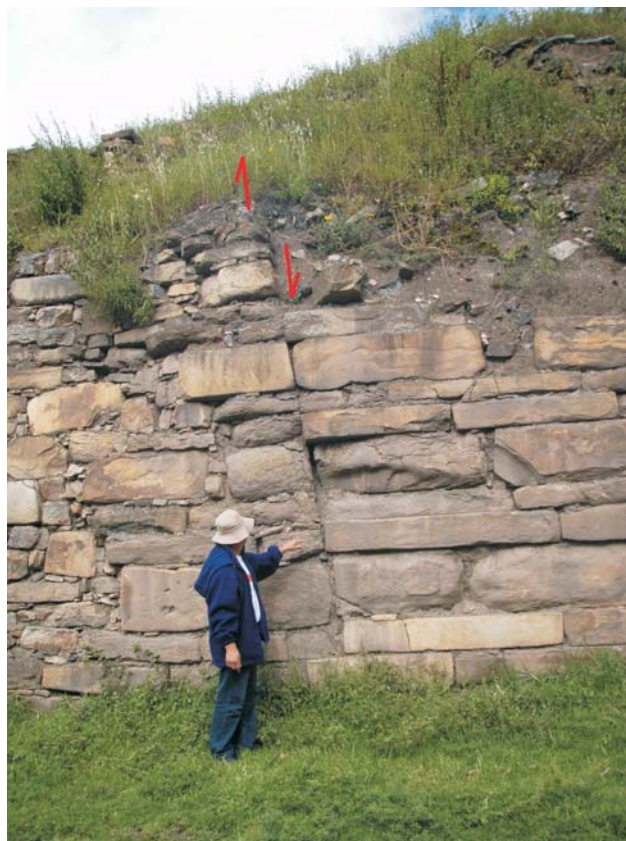
Ryc. 3. Mur świątyni preinkaskiej w Chavin de Huantar. Przestrzenie pomiędzy blokami są wypełnione piaszczystą zaprawą. Na niektórych widać spękania lub uskoki. Fot. A. Świerczewska
