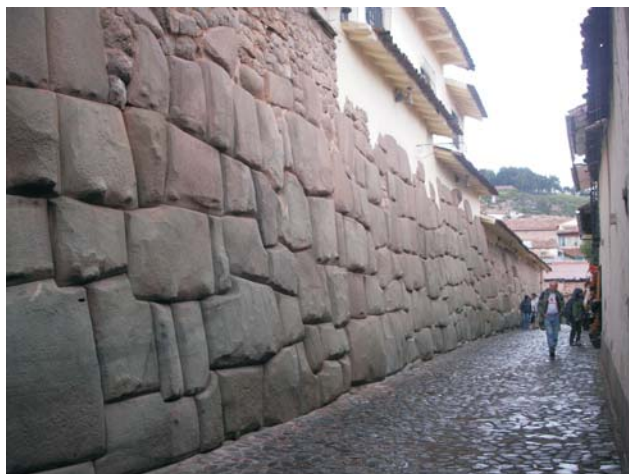
Ryc. 2. Mur inkaski w Cuzco. Ściśle dopasowane bloki granitowe ułożone bez użycia zaprawy są pozbawione spękań. Fot. A. Świerczewska
