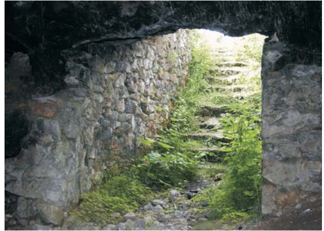
Ryc. 8. Wejście do Jaskini Magazyn
