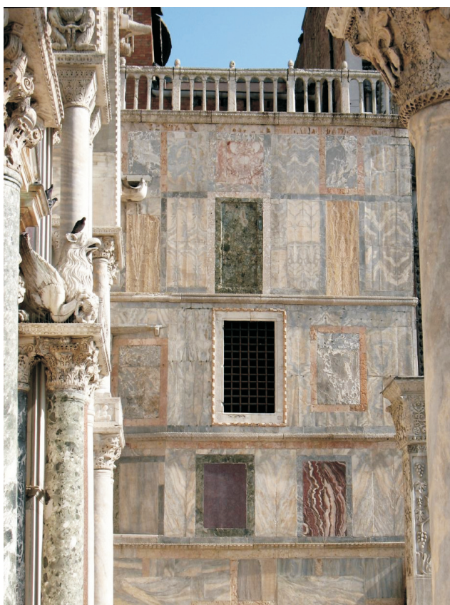
Ryc. 3. Łącznik Pałacu Dożów z Bazyliką św. Marka. Elewacja jest wykonana z kilku rodzajów marmurów
