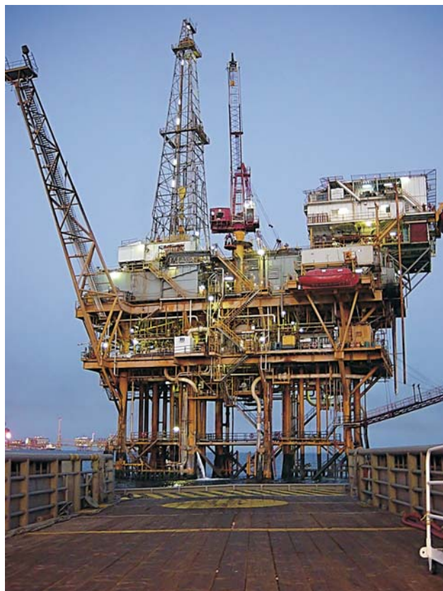
Ryc. 1. Platforma naftowa w Zatoce Meksykańskiej ( http://commons.wikimedia.org/wiki/File:Gulf_Offshore_Platform.jpg )
